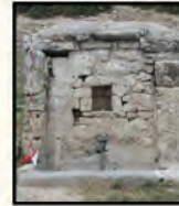
Eşme Güllü Köyü Yeni Çeşme
