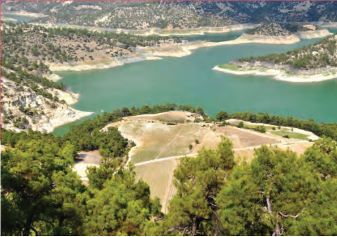
Foto 6 Kanyon tabanında, tarım yapılan alanlar. Kanyonu sınırlayan eğimli yamaçlar, tahribat neticesinde çıplak kayalık alanlar haline gelmiştir.
