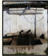
Banaz Karaköse Köyü Mahalle Çamaşırhanesi Çeşmesi
