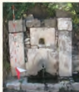
Eşme Karaömerli Köyü Güzelköy Mahalle Çeşmesi I
