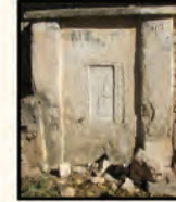
Sivaslı Yenilerce Köyü Köy Çeşmesi
