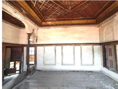
B: Odanın batı duvarı
