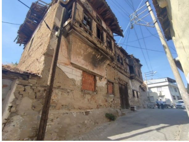
Resim 3: Hacı Kabakçılar Konağı
