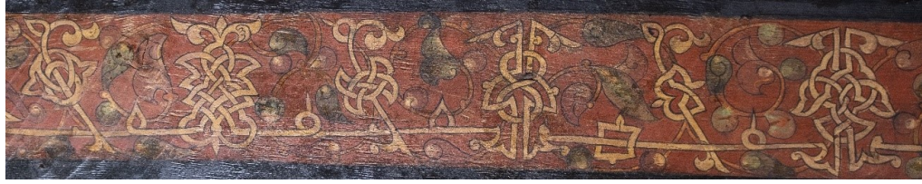
Fotoğraf 56: Bey Mahfilinde bulunan ahşap üzeri kalem işi bezemeler detay
