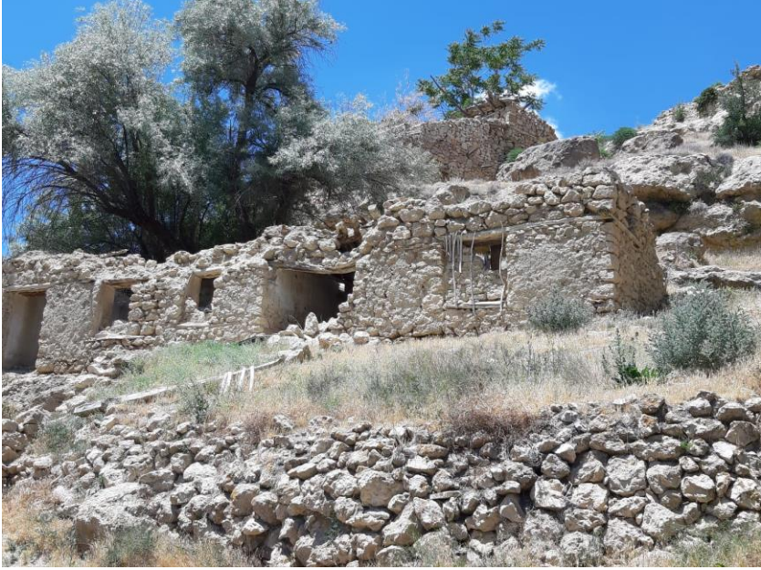
Ek.11.Kızıllarağini Köyünde Heyelan Nedeniyle Kullanılmayan Bir Ev
