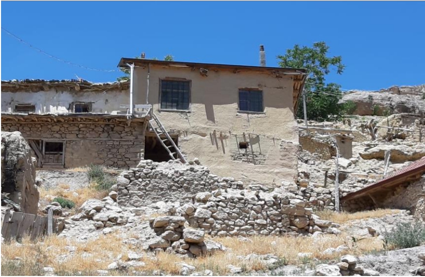
Ek.8.Kızılarağini Köyünde Heyelan Nedeniyle Kullanılmayan Evler
