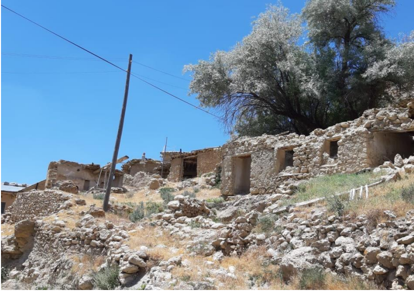
Ek.9.Kızılarağini Köyünde Heyelan Nedeniyle Kullanılmayan Evler
