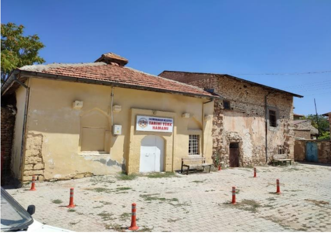
Ek.8.Kâzım Karabekir Belediyesinin Restore Ettiği Tarihi Hamam
