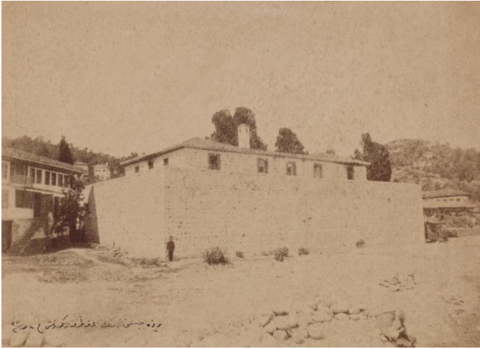
Foto. 2: Rize Hapishanesi ve Muhafaza Duvarı (BOA, FTG. f. No. 1761)
