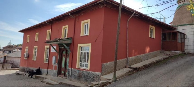
Doğu ve kuzey cephe görünümü
