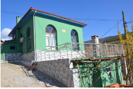
Güney ve batı cephe görünümü
