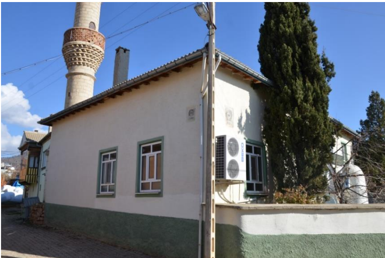
Güney ve batı cephe görünümü
