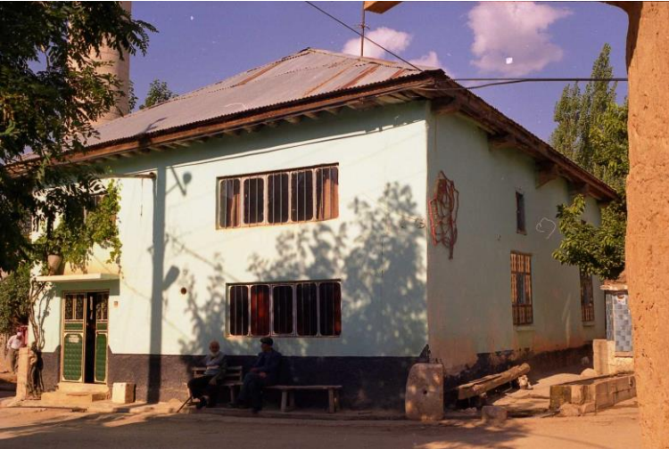
Caminin onarım öncesi durumu
