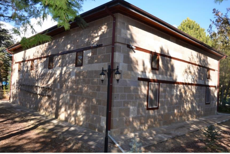
Güney ve batı cephe görünümü
