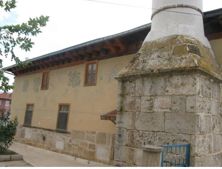
Doğu cephe görünümü
