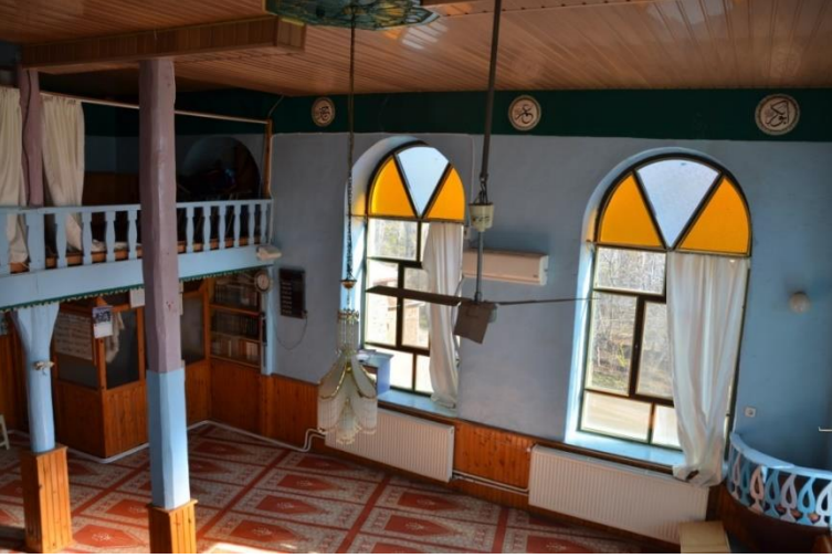
Harim batı duvar görünümü
