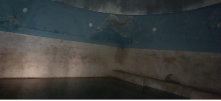
Kaplıcanın iç görünümü
