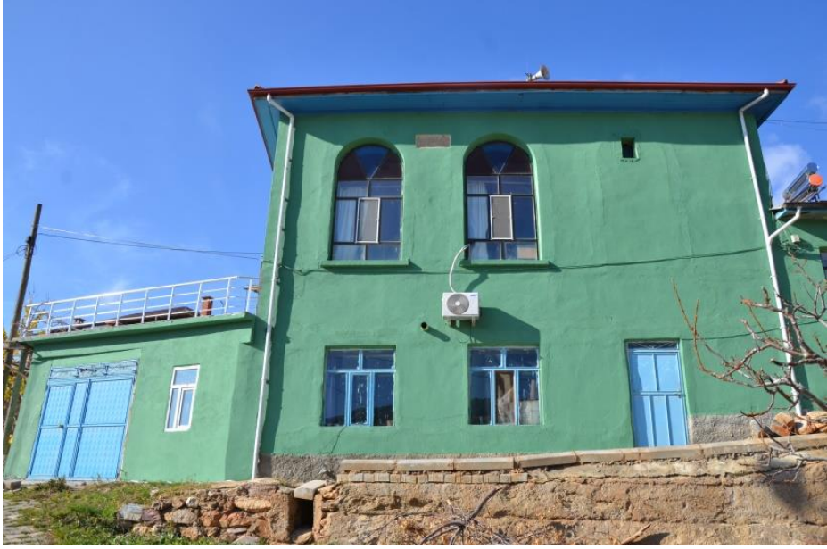
Doğu cephe görünümü
