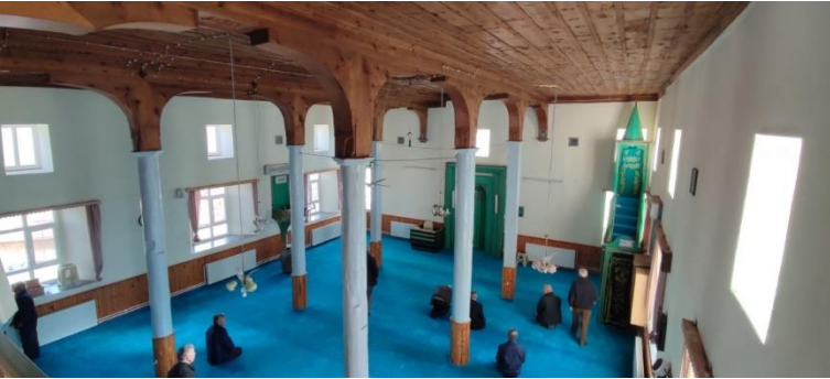
Ahşap destek sistemi
