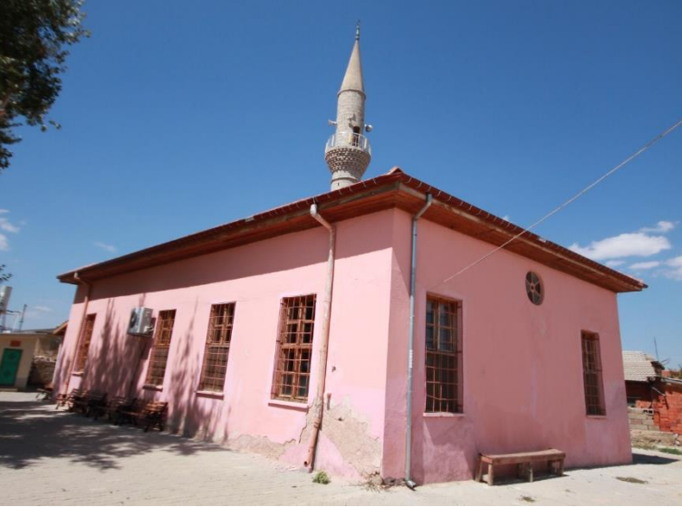
Güney ve batı cephe görünümü
