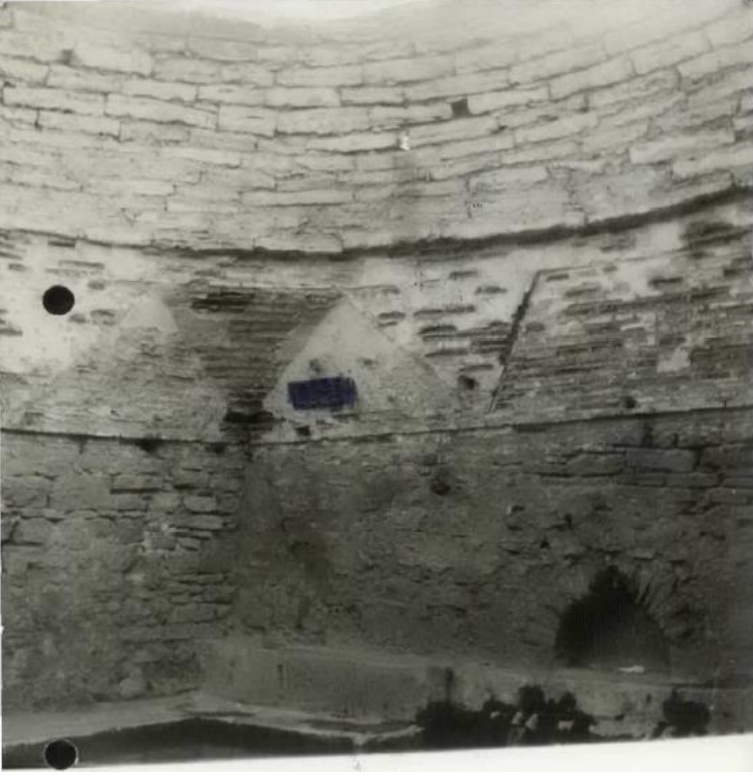
Kaplicanın onarım öncesi durumu (Konya KUDEP Arşivi)
