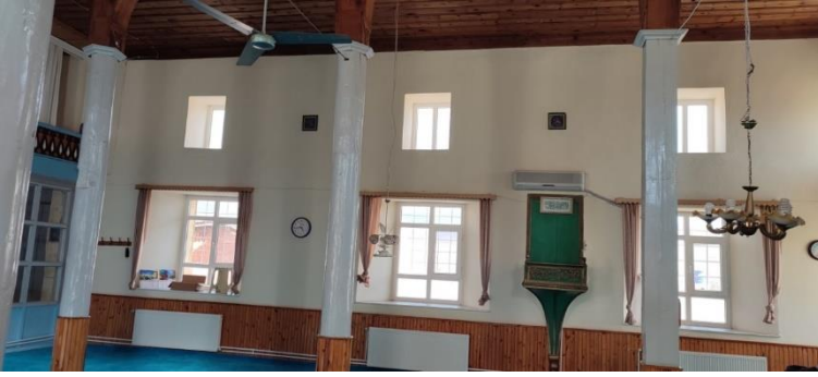
Doğu cephe görünümü
