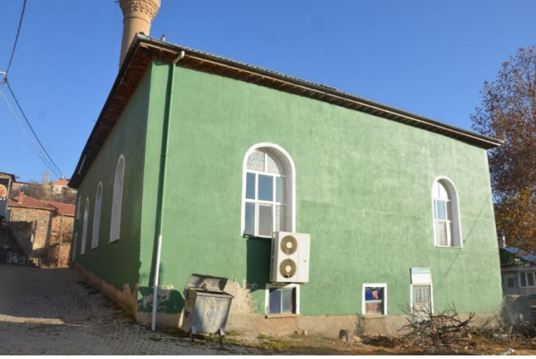
Güney ve batı cephe görünümü
