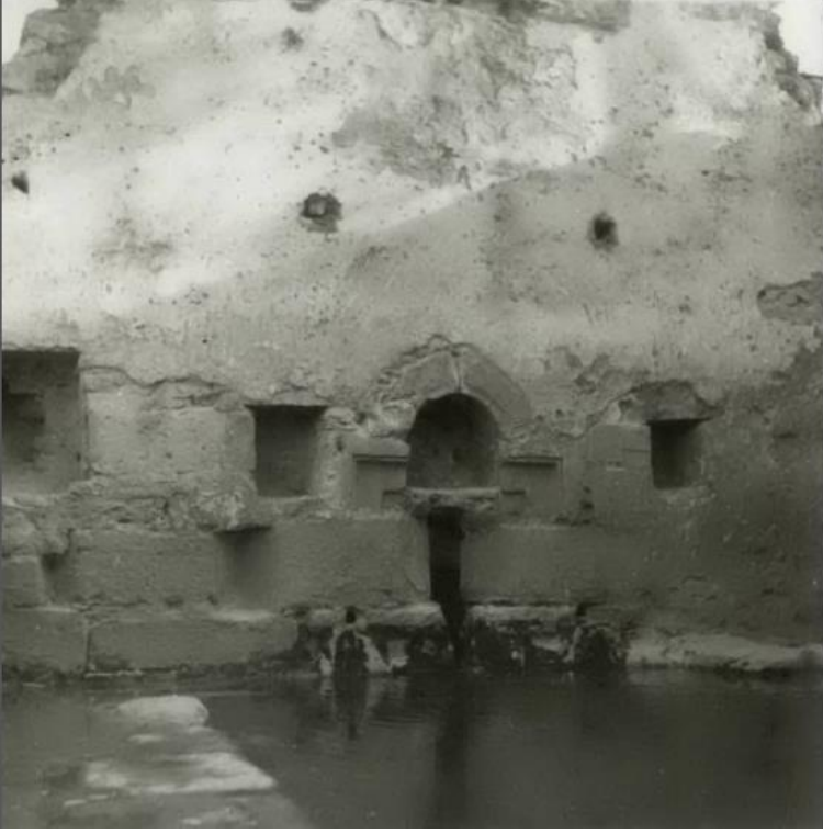
Kaplıcanın onarım öncesi durumu (Konya KUDEP Arşivi)
