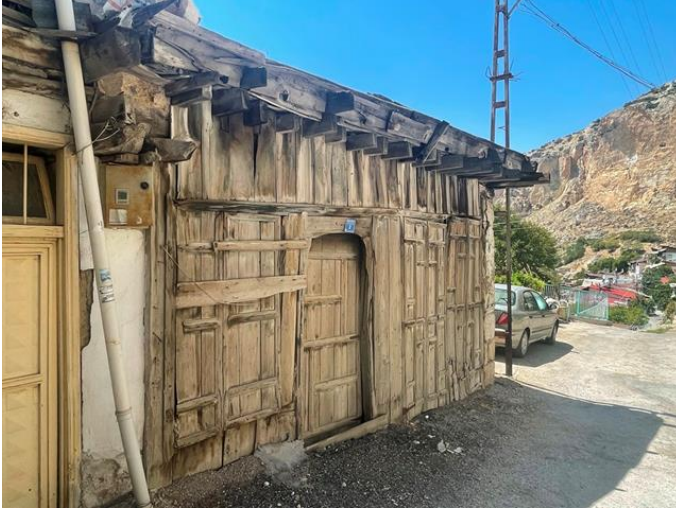
Şekil 4. Ermenek evlerinin inşasında kullanılan ahşap malzeme.
