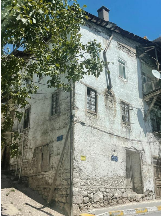
Şekil 5. Ermenek'te ahşap hatıllı, moloz taş duvarlı ve çamur sıvalı bir ev.
