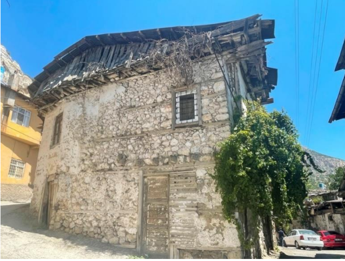
Şekil 3. Ahşap hatıllı, moloz taştan inşa edilmiş bir Ermenek evi.
